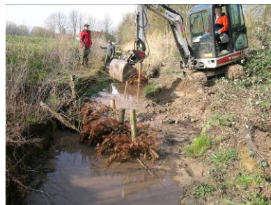
Unterhaltungsmaßnahmen bei Gewässern, z.B. Behebung der Gewässereintiefung
