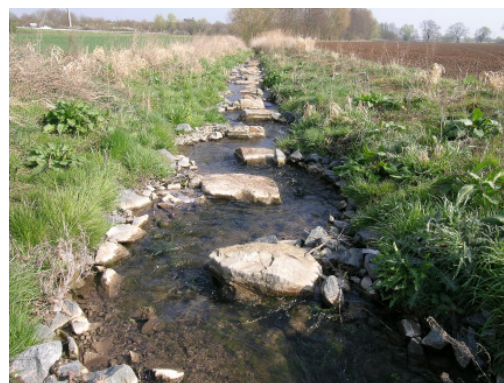
links: undurchgängige Betonrampe, rechts: neue, durchgängige Gleite mit Störsteinen
